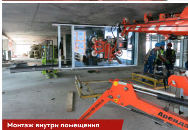
Монтаж радиального (изогнутого) стекла
