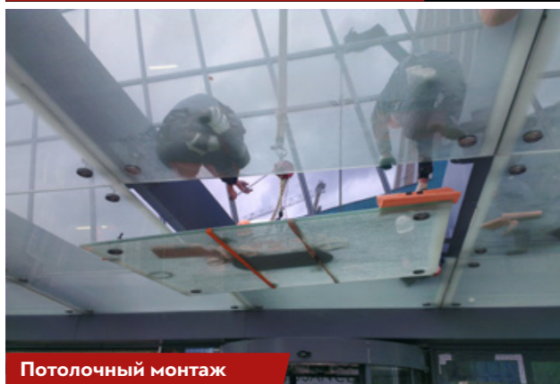
Монтаж крупногабаритного стекла
